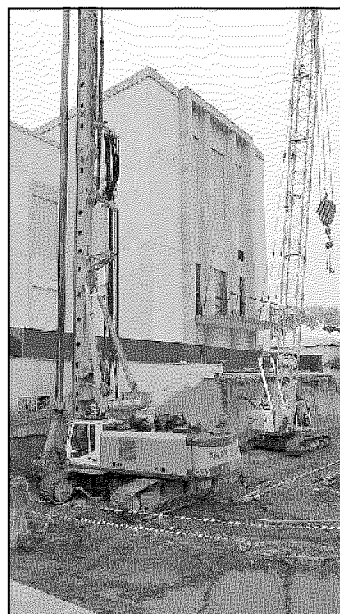
PALACINEMA Il cantiere
